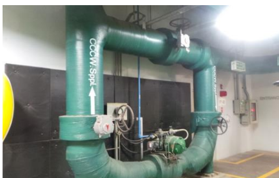
รูปที่ ค-3 การหล่อหุ้มระบบหล่อเย็นแบบปิด (Closed Cycle Cooling Water System) ด้วย Absorber เพื่อลดระดับเสียง
