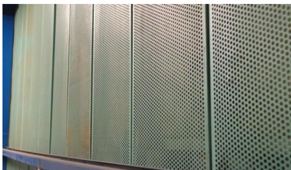
รูปที่ ค-6 การสร้างห้อง Control Room ด้วยวัสดุดูดซับเสียง
